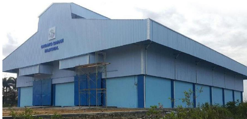
Gambar 1.2 Penyimpanan gudang garam nasional
