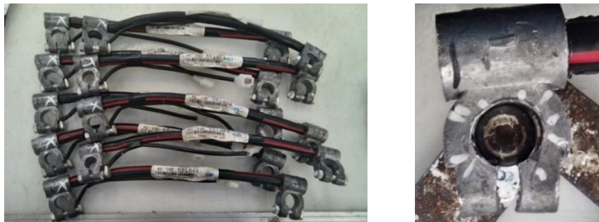
Gambar 1.1 Battery cable tipe MK 551864 yang mengalami defect (Sumber data: departemen Quality Control PT. XYZ)
