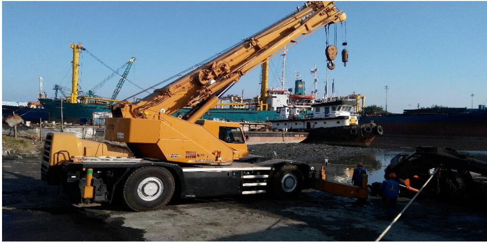
Gambar 1.1 Mobil Crane Milik PT Dewa Ruci Agung Sumber : Data Primer Dari Foto Penulis
