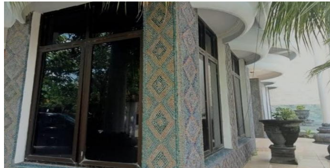
Gambar 1.2 Dinding yang ditemplei kelereng sebagai ciri khas rumah Kiai Ali Mursyid
